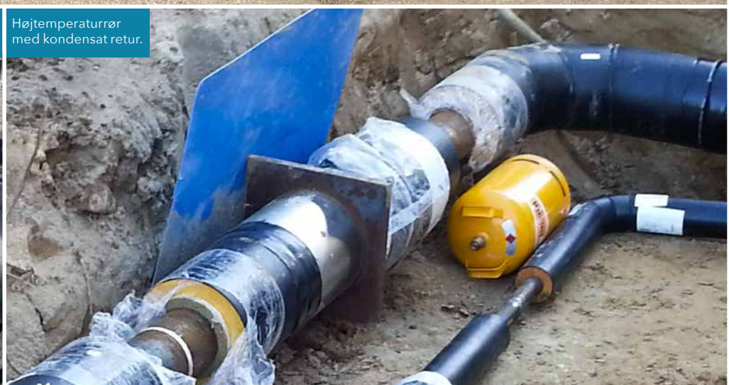
Isolerede højtemperaturforankringer.
