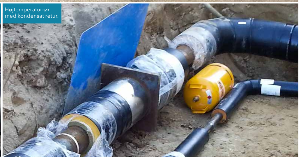
Isolerede højtemperaturforankringer.
